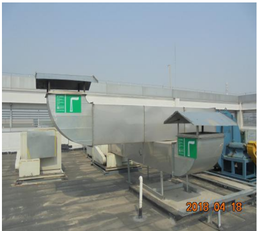
图 2 废气排气筒
