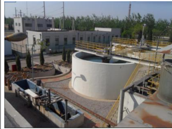
图 1 厂区内污水处理站照片
