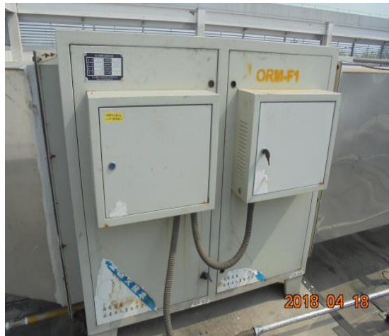
图 1 油烟净化装置
