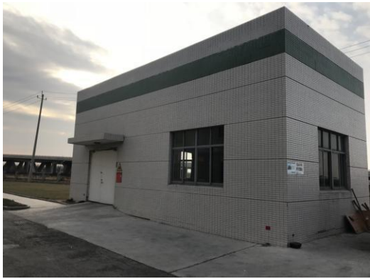
图 1 危险废物暂存场所
