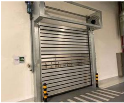
一般固废暂存间
