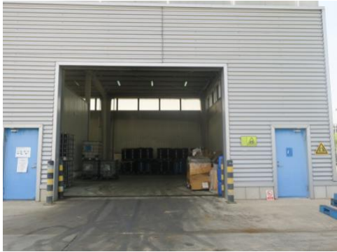
危废暂存库外部
