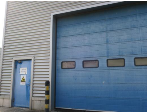
生活垃圾暂存间
