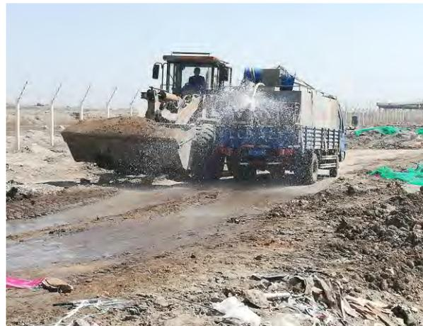
图 6-3 施工期喷淋抑尘措施
