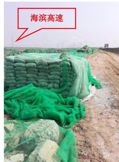
图6-8 施工期建筑材料苫盖措施
