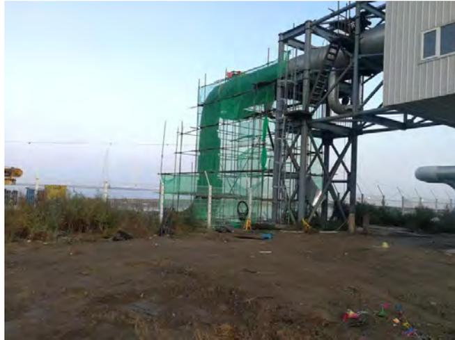
图 4-1 电厂连接管部分架空敷设
