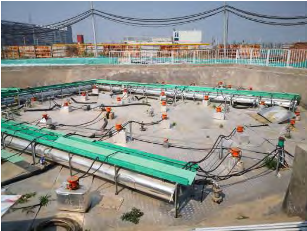
图 5.1-3 基坑保温层实景图
