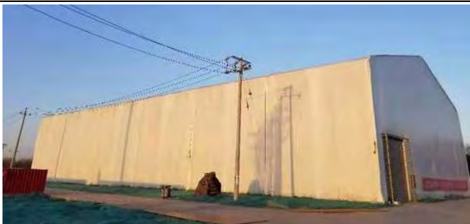
密闭修复车间外部实景图
