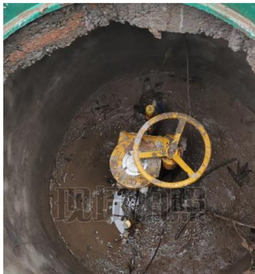
图 4-10 燃气管道应急截断阀
