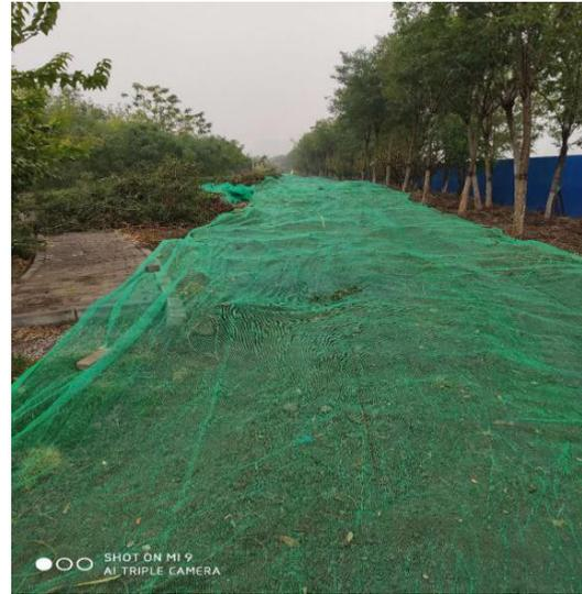
图 4-8 施工期玉砂道管道施工附近苫盖措施
