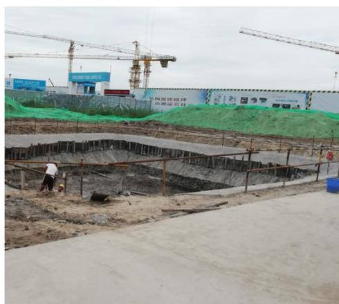
图 3-3 施工场地内路面硬化及临时土方苫盖
